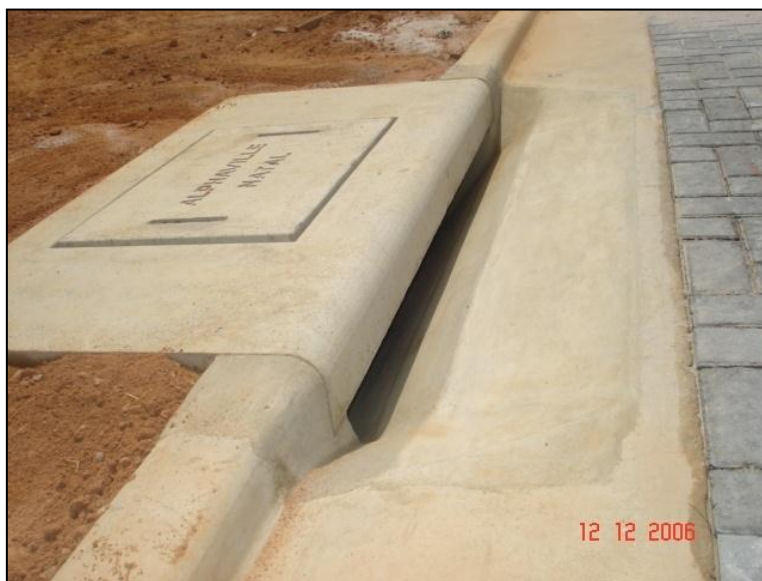
Figura 6 - Boca de lobo simples vazada.
