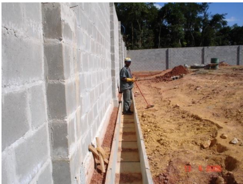
Figura 10 - Execução das canaletas pré-moldadas.
