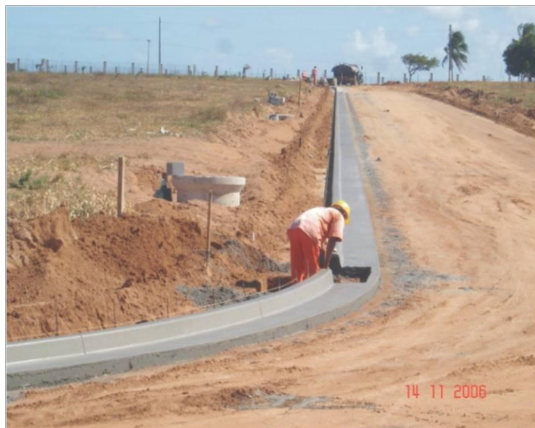
Figura 3 - Acabamento de guia com abertura para boca de lobo.
