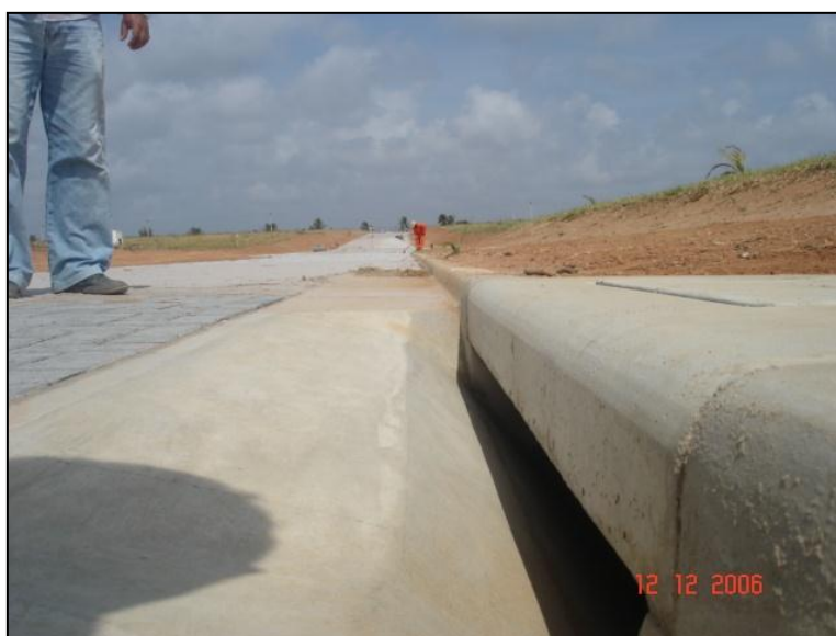
Figura 7 - Detalhe de declividade longitudinal da sarjeta.
