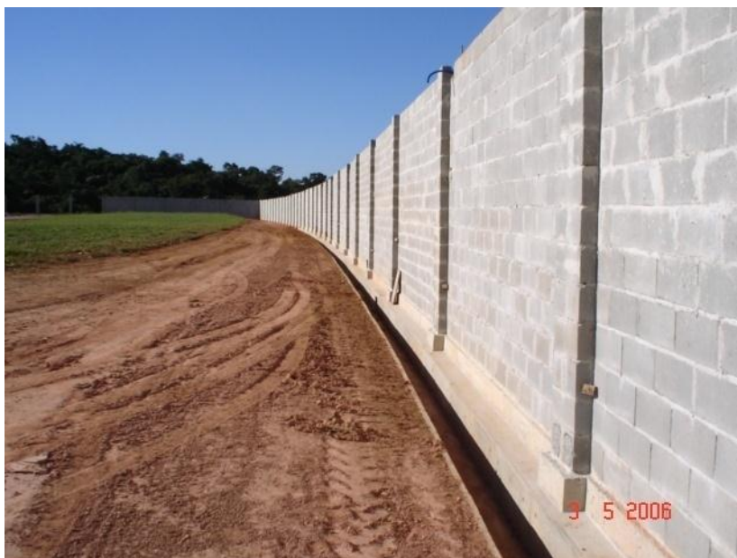
Figura 13 - Acabamento da execução das canaletas de pé de muro
