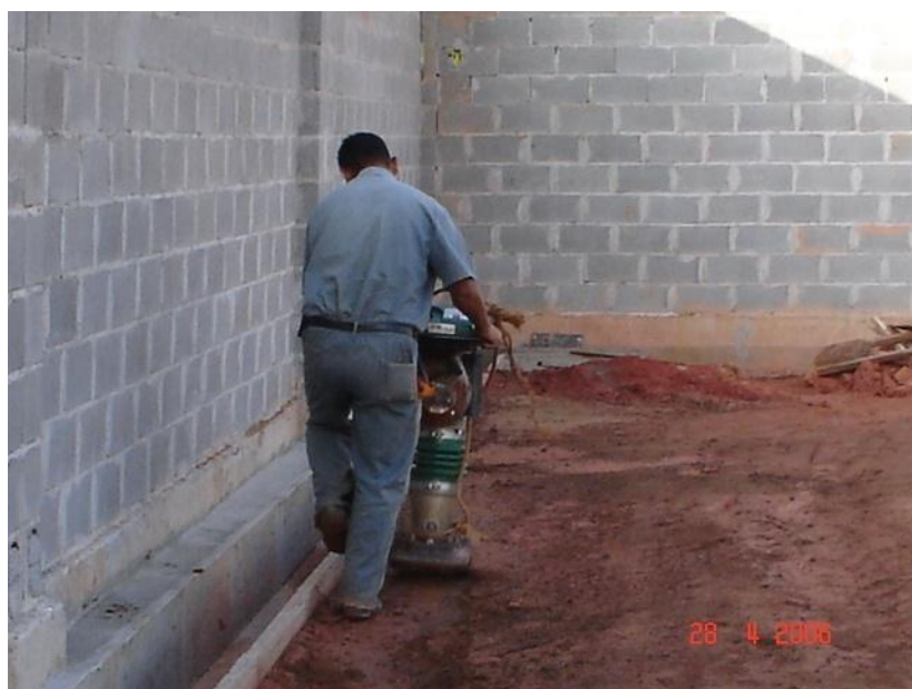
Figura 11 - Execução da compactação próximo as canaletas pé de muro.
