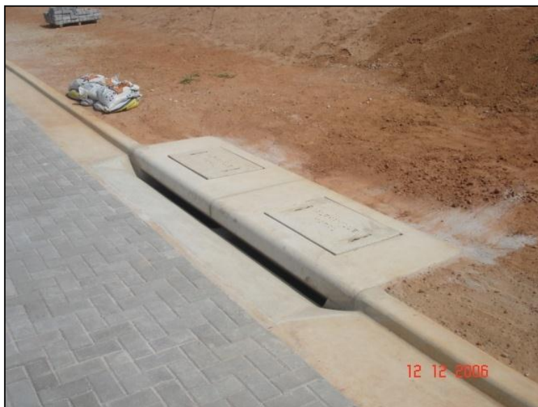
Figura 4 - Boca de lobo dupla vazada.
