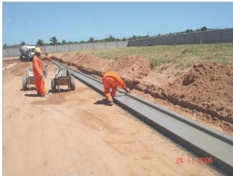
Figura 2 - Execução de guia e sarjeta extrusada
