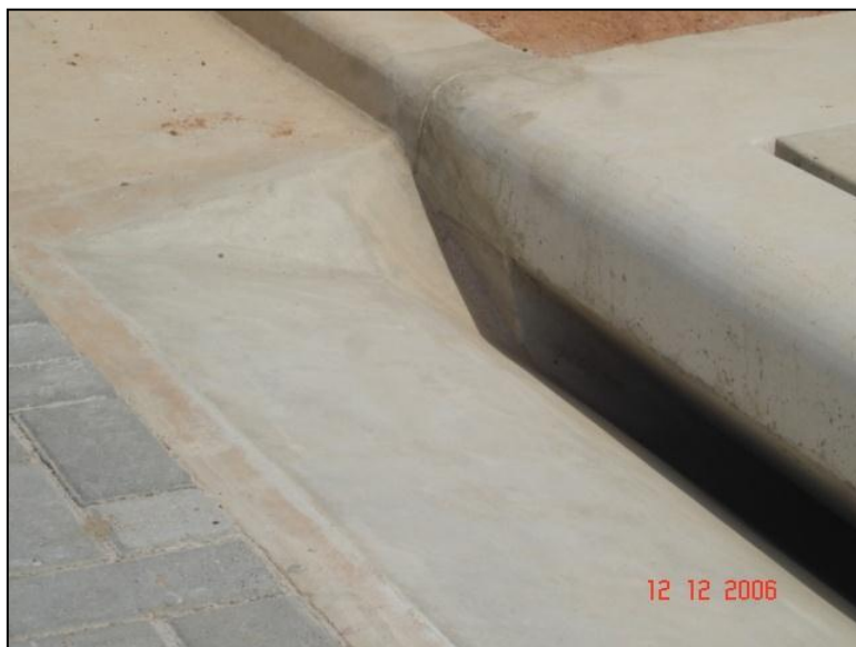
Figura 5 - Detalhe da inclinação da sarjeta para captação das águas.
